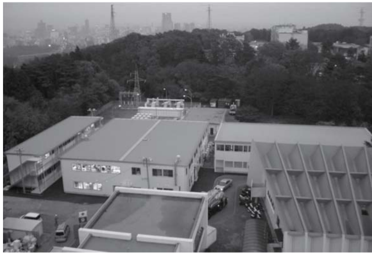
建設されたプレハブ群：右手前が101大講義室。
