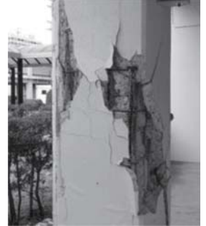
本震後———>余震後：4月7日の最大余震で北講義棟の柱部分の損傷が進む。
