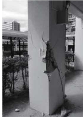
本震後———>余震後：4月7日の最大余震で北講義棟の柱部分の損傷が進む。
