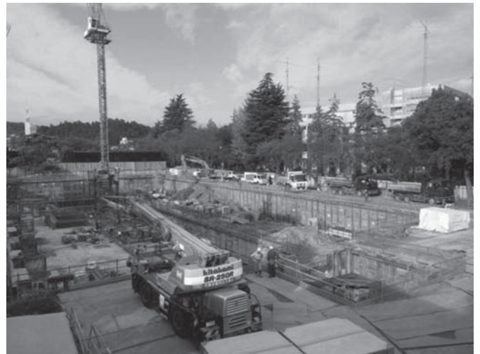
工事の進捗状況(平成25年11月)
